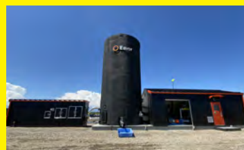
Le puits géothermique d'Eavor Technologies
