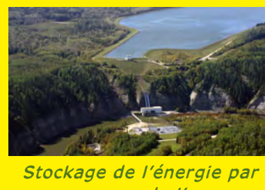
Stockage de l'énergie par pompage de l'eau
